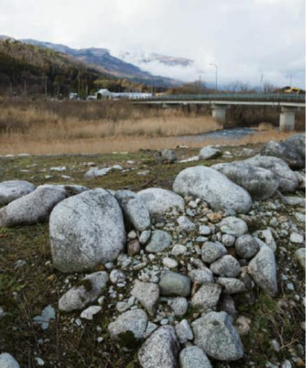
野川の水害から長井を守った「平山の締切堤防」の遺構。総石積みで、長さは450mにも及ぶ
